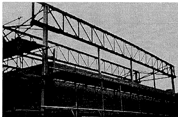
Fig. 2 Stalen vakwerkliggers met vallende diagonalen
