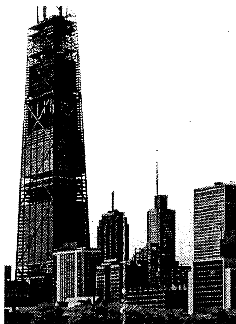
Fig. 3 John Hancock Building Chicago in aanbouw Amerikaanse wolkenkrabbers zijn in principe stalen raamwerken. Ter verstijving zijn in dit geval ook vakwerkdiagonalen aangebracht.
