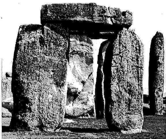
Fig. 3 Stonehenge; losse stapeling van vrij grof bewerkte blokken
